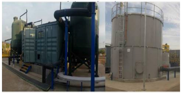
Filtros de arena y tanque agua producto.
